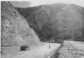
Un di e hechonan sobresaliente di autopista nobo ta e cantidad minimo di curbo. E camina bieuw tabatin 365, e nobo solamente 36. Unda necesario, curbonan a wordo traha pa duna maximo seguridad. Ariba e retrato ta Curbo No. 4.
